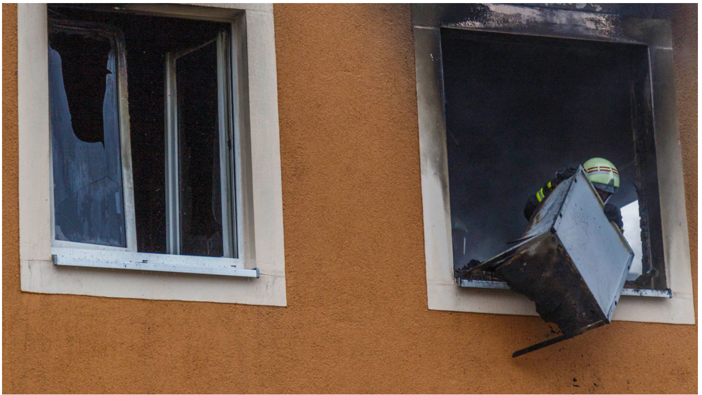
_ Zur Sicherheit werden verbrannte Möbel aus dem Fenster nach draußen gebracht | Foto: Jens Uhlig
