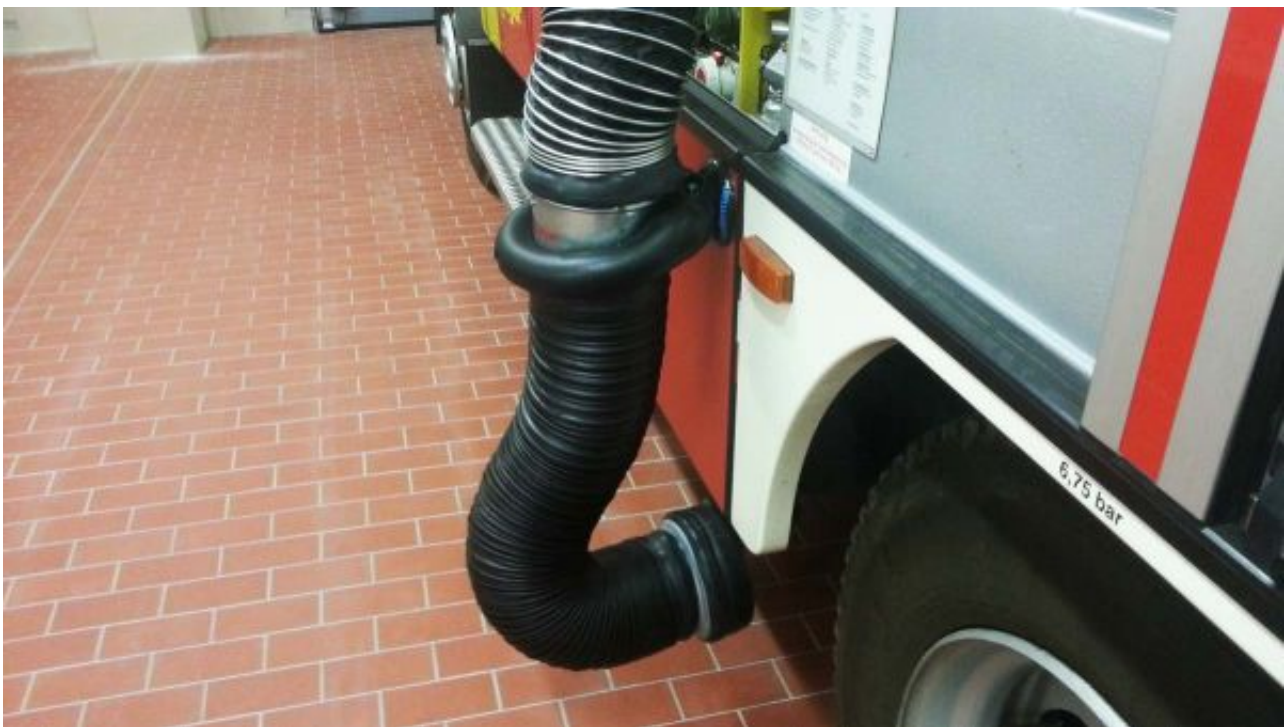
Abgase werden jetzt abgesaugt | Bild: FF Lugau/Schimmel
