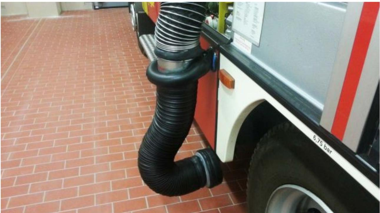
Abgase werden jetzt abgesaugt | Bild: FF Lugau/Schimmel
