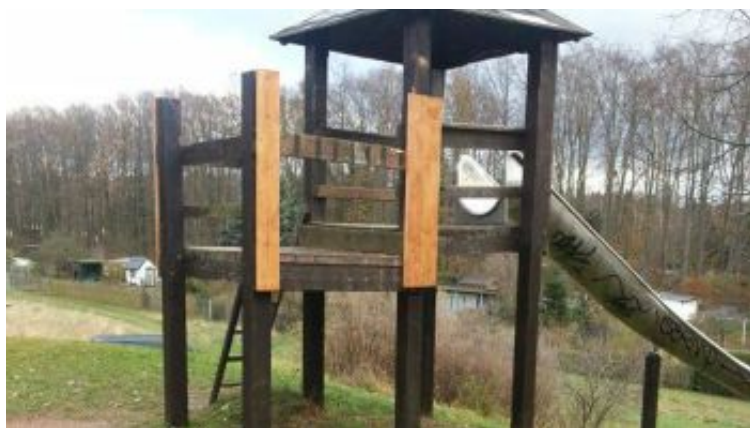
Wieder Zerstört: Neue Holzverkleidung
