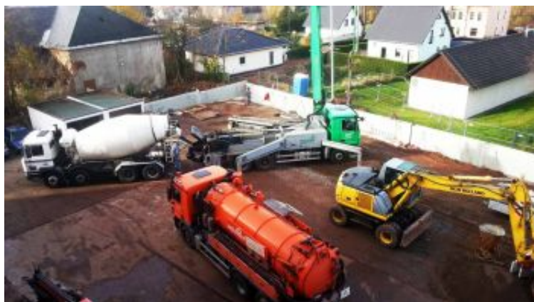
„Die Mauer muss her!“ - Bauarbeiten im Feuerwehrgelände schreiten voran
