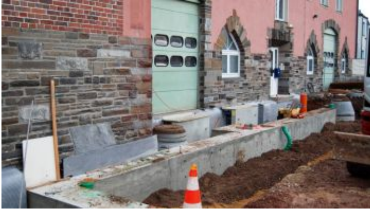
Der Baustand im Februar 2015
