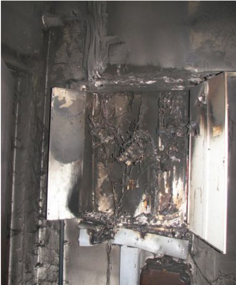
Nach Kabelbrand ausgebrannter
