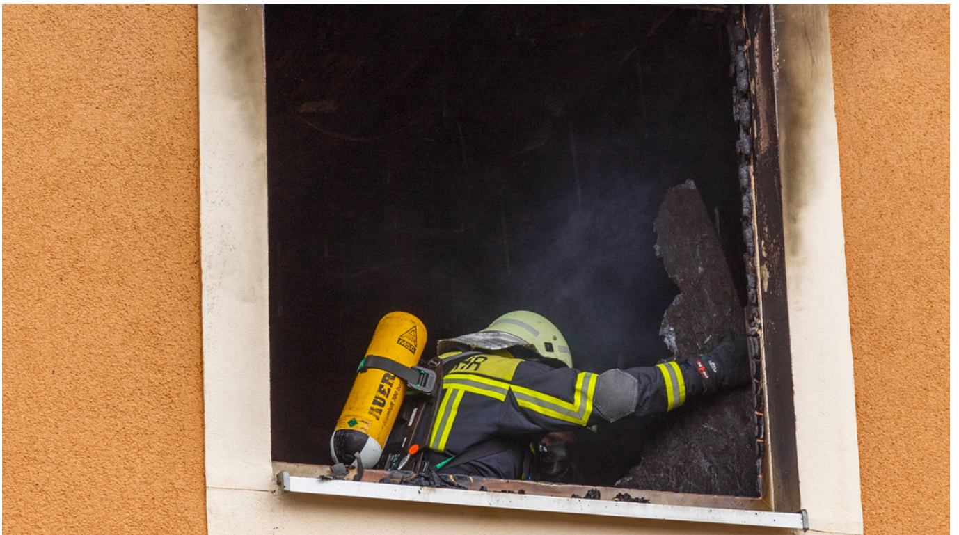
_ Teile der Wandverkleidung müssen herausgenommen werden | Foto: Jens Uhlig
